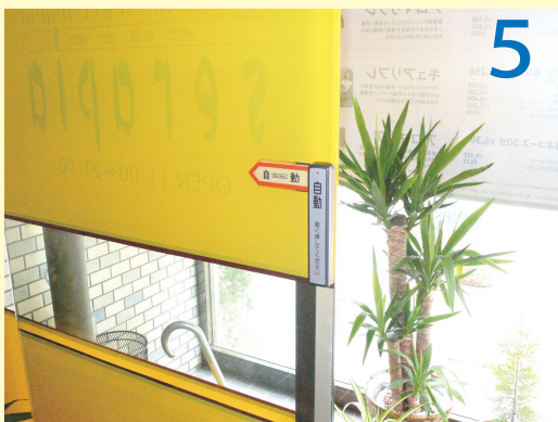
5 後から取り付けた自動ドアの押しボタン。
