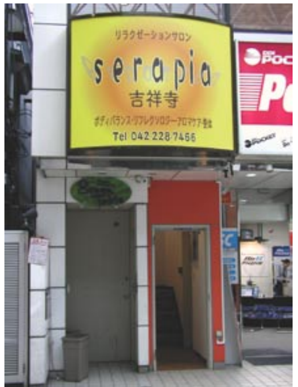
1階部分(右)の鉄の扉が入り口を狭く見せていたがシャッターに換えた。外看板はアールがついているので遠くからで目立つ。隣の派手な看板にも負けていない。
