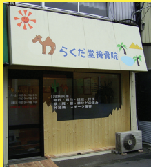
外観と受付壁工事 工期 2 日 16 万円
